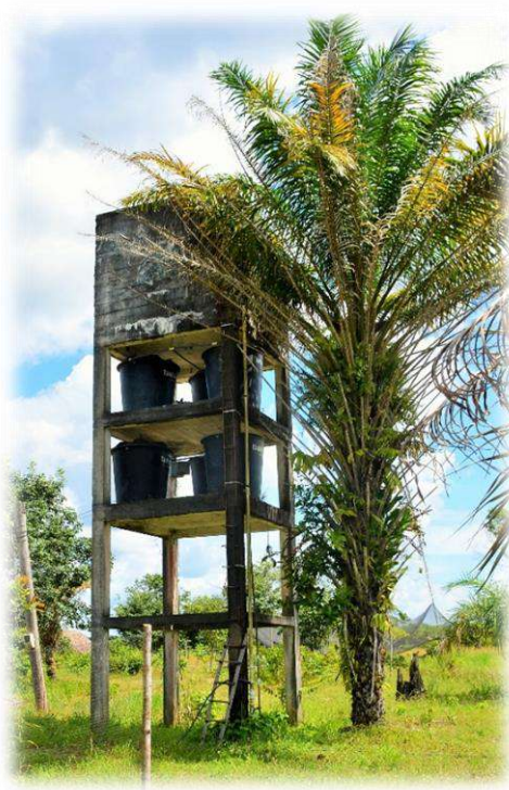
Tanque elevado Sabanitas. 2017
